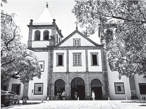
Mosteiro de São Bento (RJ)
